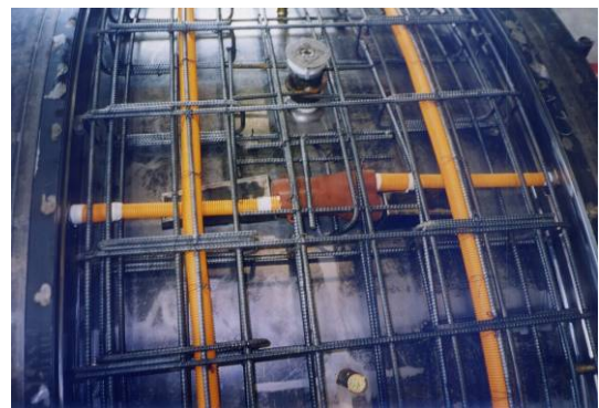
写真 4.5-2 軸方向 X アンカーの固定
