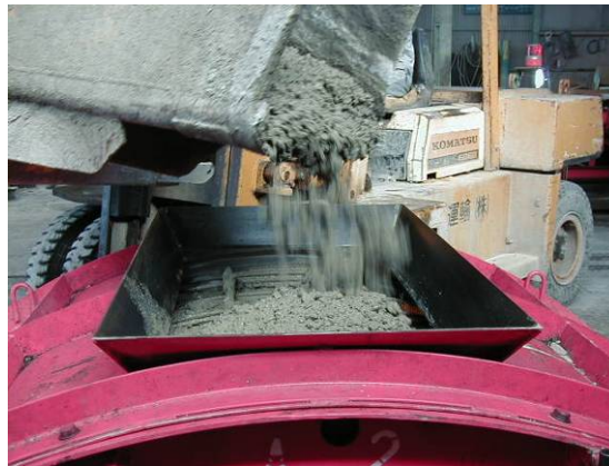
写真 4.6-1 コンクリート打設
