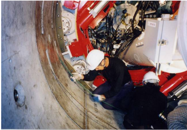
写真 4. 3-1 P C 鋼より線の挿入状況
