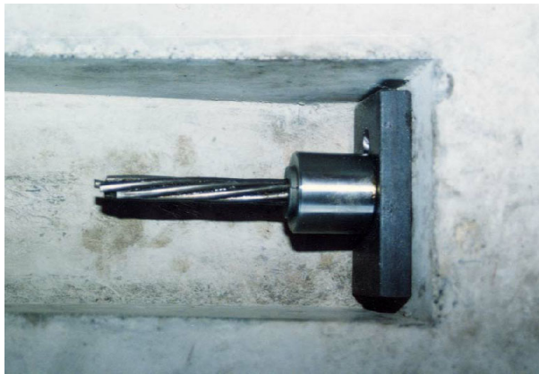
写真 7.4-1 支圧板+グリップ方式の例
