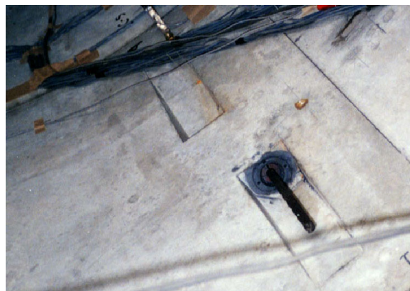
写真 4. 3-5 P C 鋼より線の定着状況
