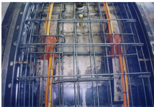
写真 4.5-1 円周方向 X アンカーの固定
