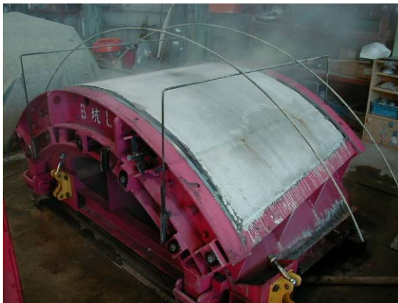
写真 4.7-1 蒸気養生終了
