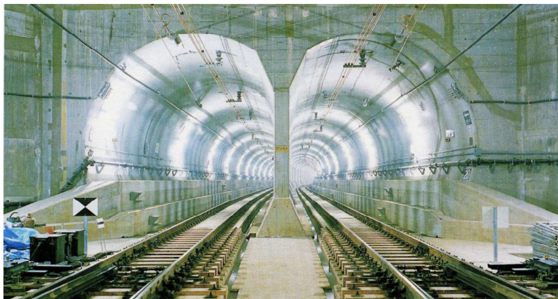
シールドトンネル坑口
