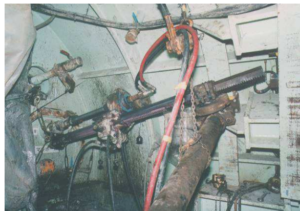
写真-1.6.2 鋼矢板撤去状況
