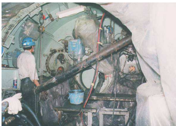
写真-1.6.1 地盤改良状況
