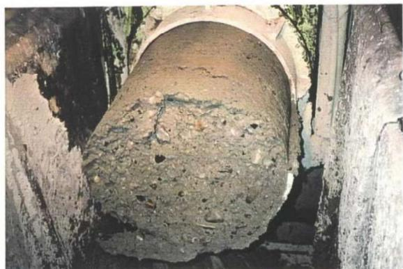
図-6. 1 砂礫層掘進時排土状況
