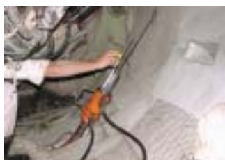
▲横浜市北部処理区 下野谷幹線工事 (セグメント外径φ2,750mm)
