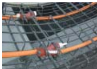
▲大阪府寝屋川流域下水道 八尾枚岡幹線工事 (セグメント外径φ3,550mm)
