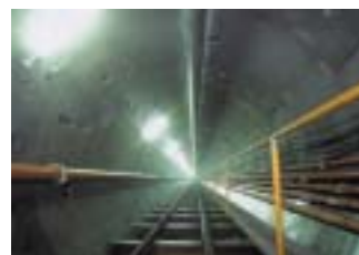
▲相模原市公共下水道 緑ヶ丘雨水幹線整備工事 (セグメント外径φ3,120mm)
