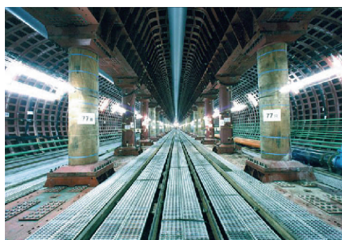
地下鉄12号線環状部飯田橋駅区区建設工事▲ (断面形状：幅17.44m×高8.846m)
