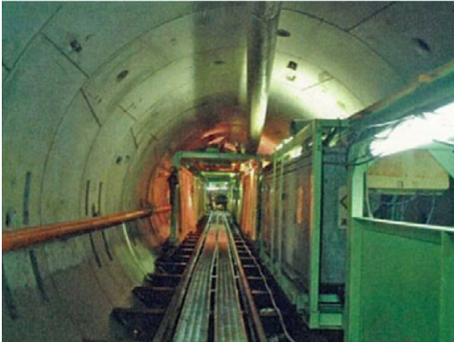
■相模原市公共下水道緑が丘雨水幹線整備工事
