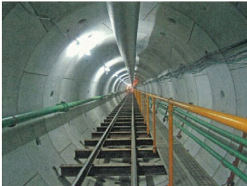
■いわき市平・鹿島水系幹線新設工事
