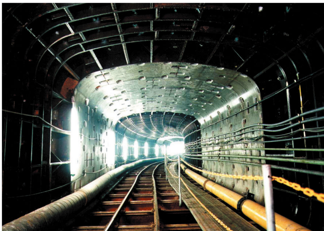
習志野市菊田川 2 号幹線曲線部施工状況 (R=50m)
